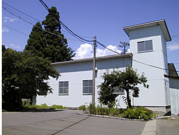
(排水処理施設)
